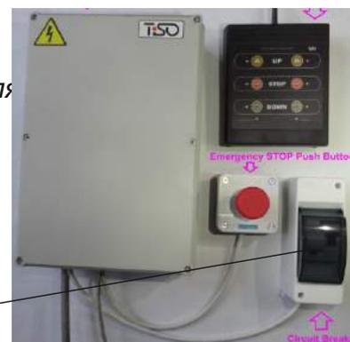
9.3.6 Электрооборудование блокиратора должно быть заземлено. Значение сопротивления между шиной заземления и каждой доступной металлической нетоковедущей частью корпуса электрооборудования блокиратора не должно превышать 4 Ом.
